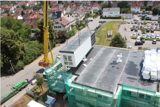
Das Gebäude der Kindertagesstätte des Klinikums erhält ein Obergeschoß, welches Raum für die neue Kindergartengruppe bietet. Am 4. Juli wurden die Module für das Obergeschoss angeliefert und aufgebaut. (Fotos: S. Gögler)
