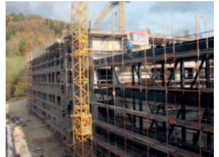
Hinten das neue Bettenhaus E, vorne der Verbindungsgang zum Bettenhaus D – das Bauwerk ist Bestandteil des Zukunftskonzepts am Klinikstandort Leutenberg.
